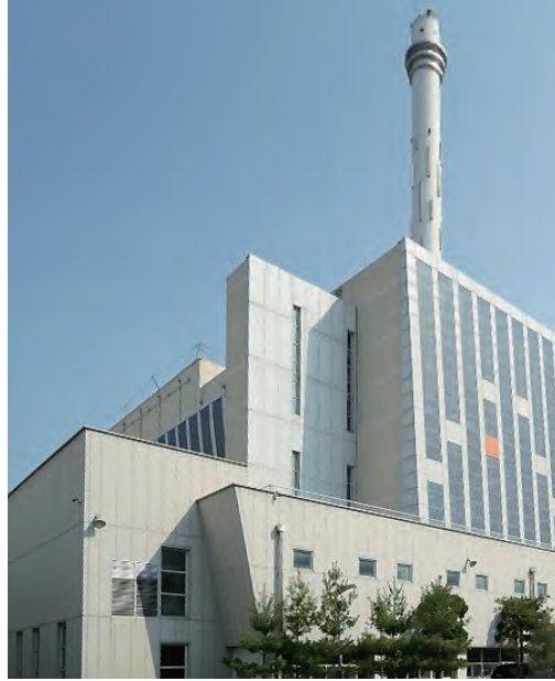
양천구 자원회수시설 촉매교체공사 2007년 11월 준공
